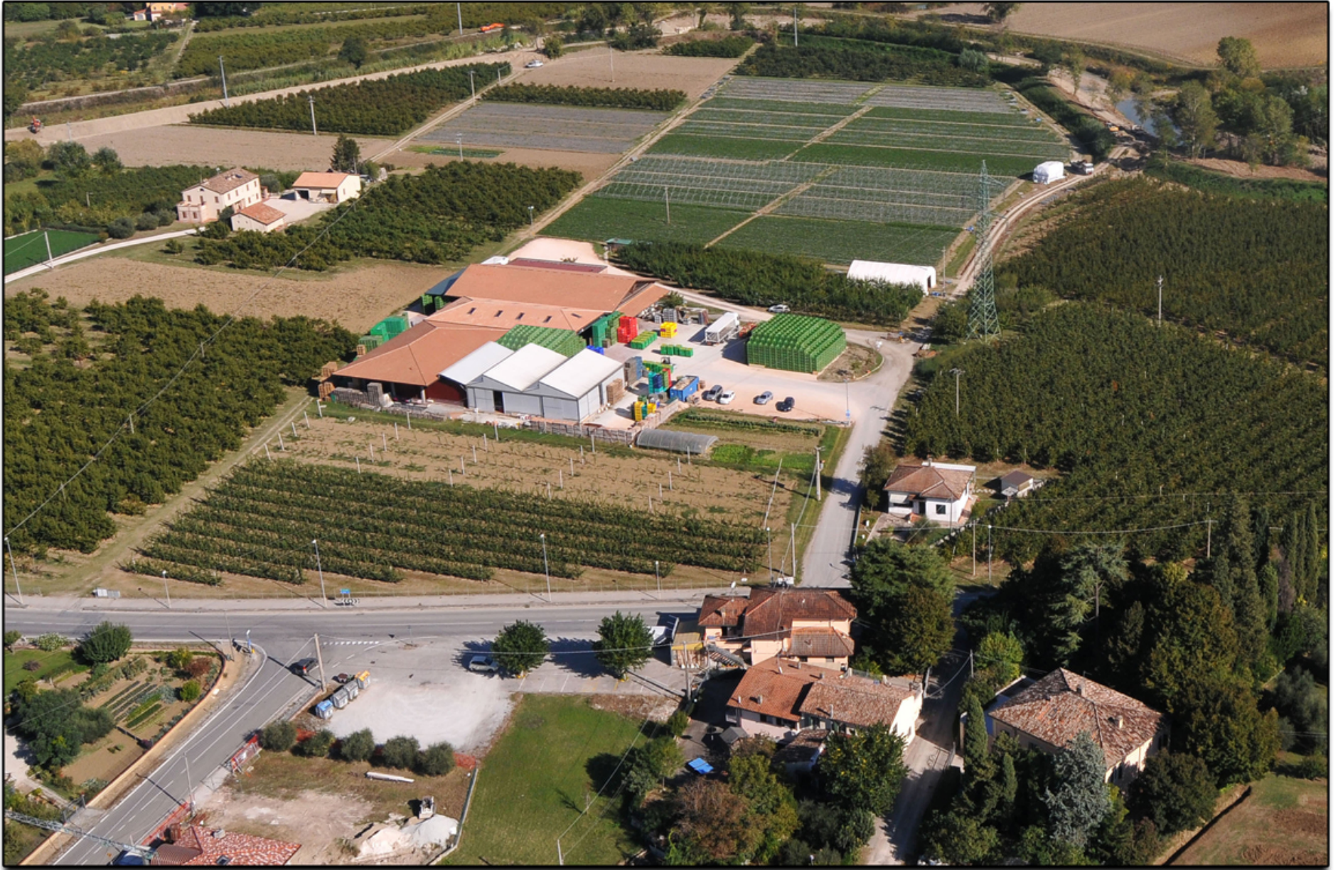
RILIEVO FOTOGRAFICO STATO DI FATTO - VISTA AEREA DA VIA DELL'USO
